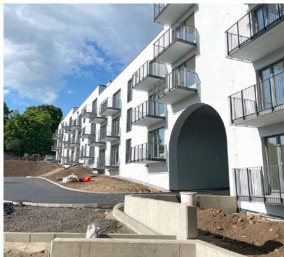
Výstavba nových městských bytů Na Žižkově
