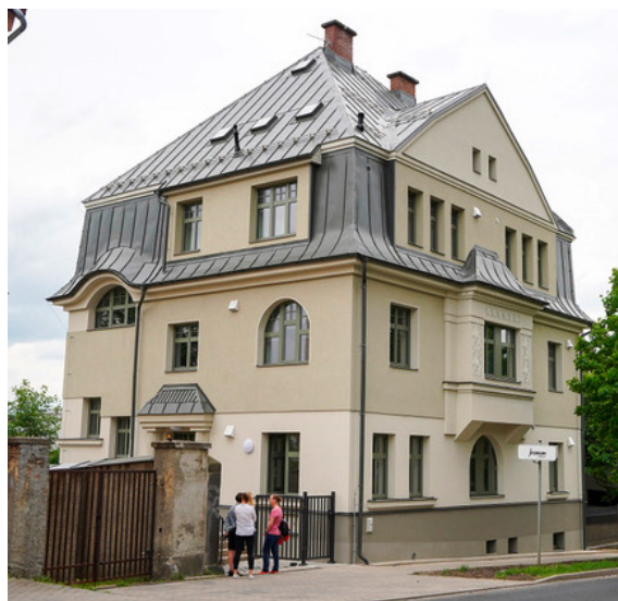
Rekonstrukce bytového domu v ul. Horákové
