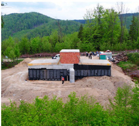
Stavba vodojemu Horská
